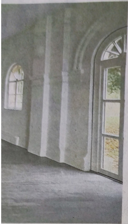
n, Wasserleitungen und die zusätzliche Tür
